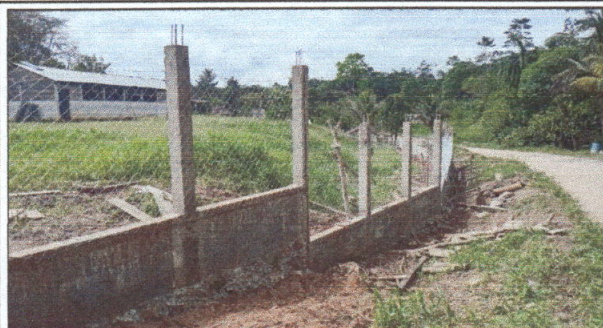
Foto 1: Finalización de remozamiento del muro perimetral del establecimiento.
