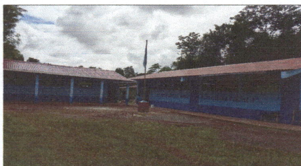
Foto 4: Finalización de remozamiento de pintura en exterior e interior de las aulas del establecimiento.
