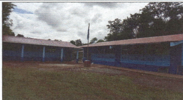
Foto 2: Finalización del remozamiento de techo de lámina del establecimiento.
